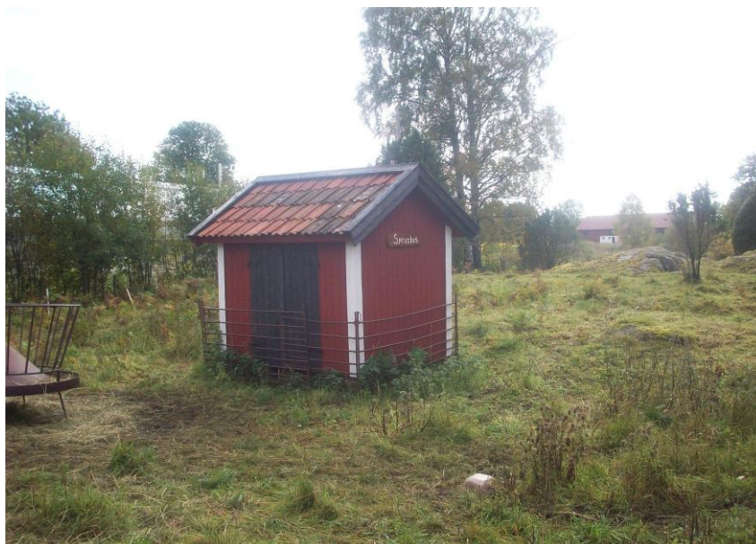
Det renoverade spruthuset på sin plats i hagen. Hösten 2011
