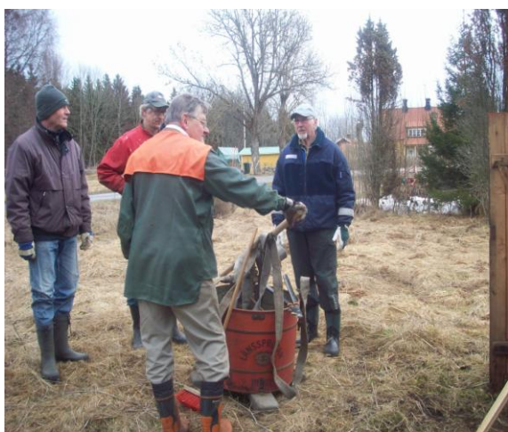
Inventering av arbete inför renovering. F.v. Onny Andersson, Dan Johansson, Kjell Westerberg och Ragnar Frid. I bakgrunden Norrgården.
