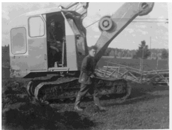
Sixten Åman från Hallstavik med sin grävmaskin (Eksjömaskin). Grävde Stordiket (avdikning vid Östnaven) runt 1950.
