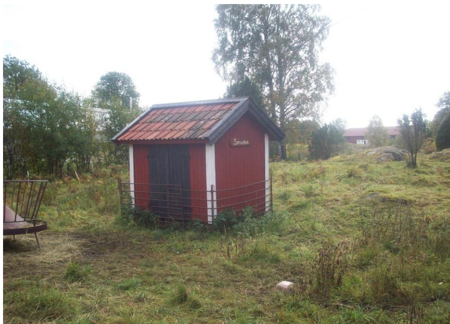
Det renoverade spruthuset på sin plats i hagen.
